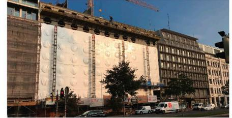
Abb.53: Betonarbeiten des 8.OG - Straßenseite; Dampfsperre (als provisorischer Raumabschluss eingesetzt); herstellen der Hebebühnen zur Erhöhung der Fassade
