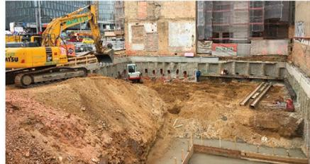
Abb.29: Kranfundament vorbereitet, temporäre Aussteifung zur Baugrubensicherung während des Ausschubs des 2 UG
