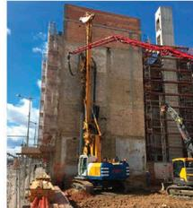
Abb.25-26: Herstellung der aufgelösten Bohrfahrgründung
